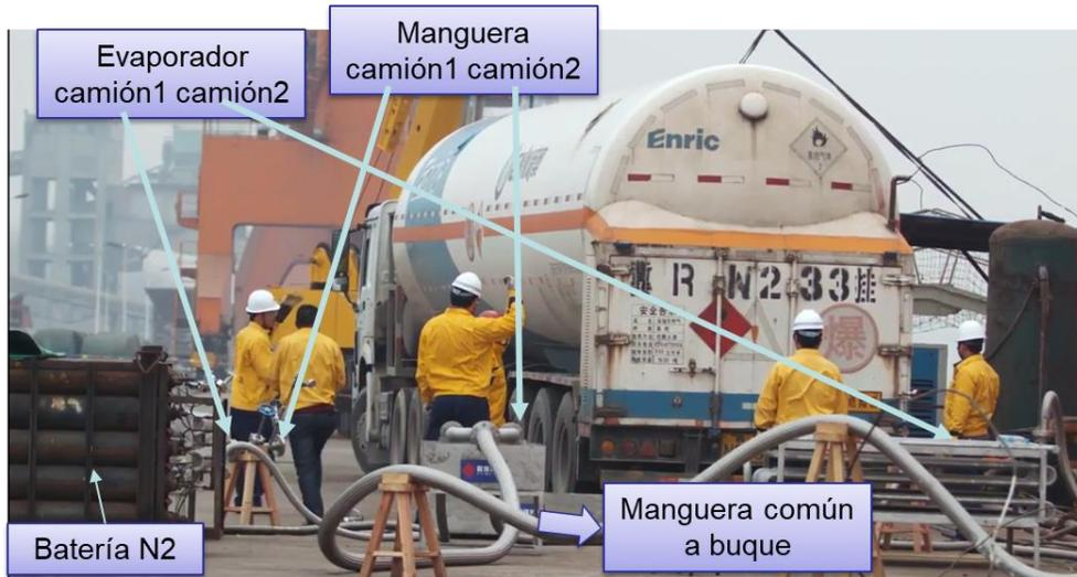
Ilustración 5-6 TTS con skid dos camiones y vaporizadores externos. China.<sup>17</sup>
