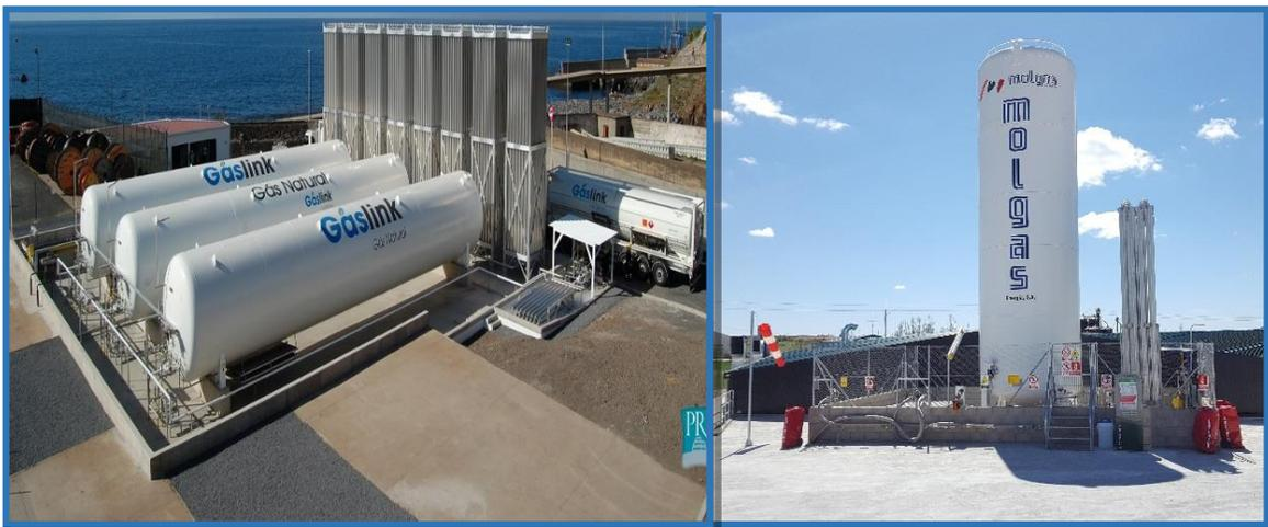
*Ilustración 4-1 Depósito a presión horizontal y vertical*
