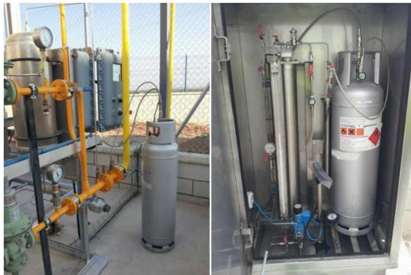
Ilustración 4-15 Odorizador de contacto (izquierda) o por bomba dosificadora (derecha) (1)
