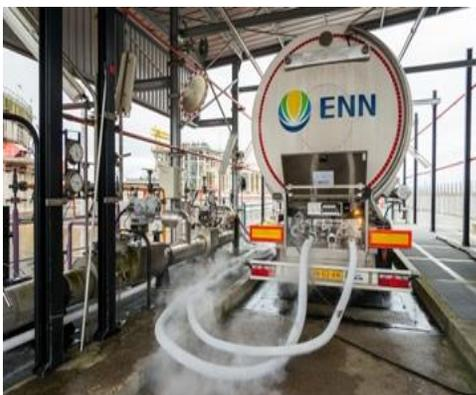
Ilustración 4-7 Cargadero de cisternas de GNL (dos mangueras L/V).<sup>Fluxys9</sup>
