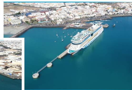
Muelle de Cruceros en Puerto del Rosario - Fuerteventura
